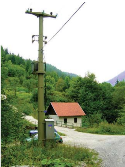
Objekt male pretočne hidroelektrarne
